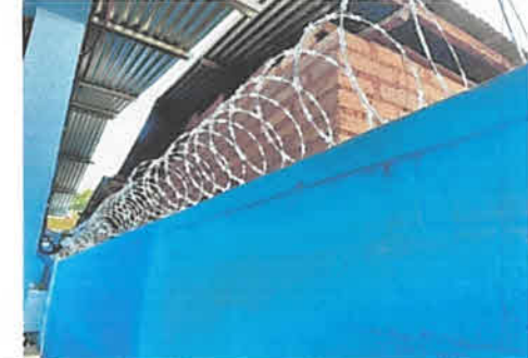
foto 6: finalizacion de instalacion de razon de seguridad
