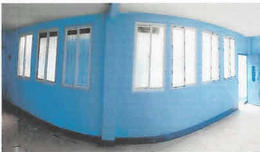
foto 5: finalizacion de instalacion de ventanas pvc
