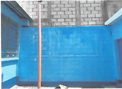
foto 9: finalizacion de muro de mamposteria en patio de juegos.
