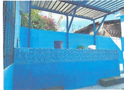
foto 10: sustitucion de nueva pileta con 2 lavaderos
