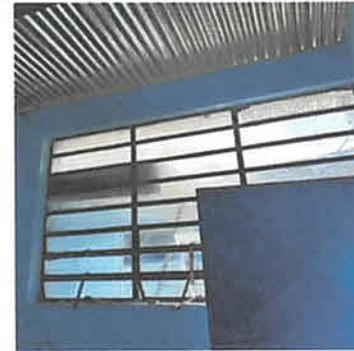
foto 8: finalizacion de limpieza de ventanas
