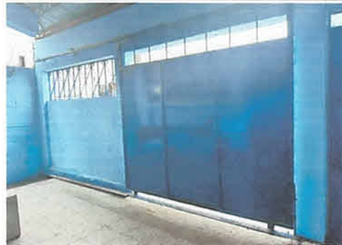
foto 4: finalizacion de instalacion de porton.
